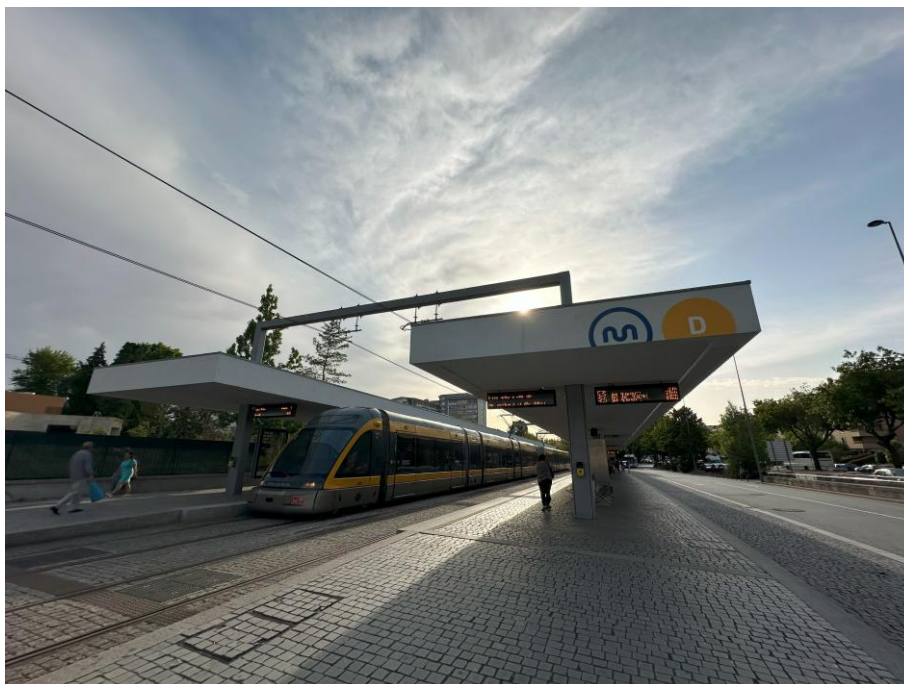
Fig. 59 Estação de Metro do Hospital de São João
