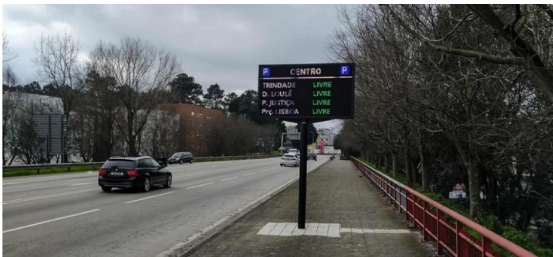
96 Painel de mensagem variável instalado na Rua de Faria Guimarães
